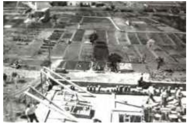
■ Construcció de l'hotel Johnstone el 1935 (AMT).
