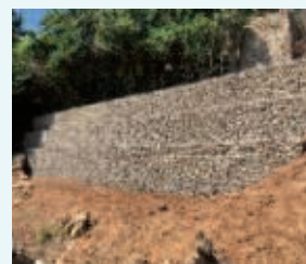
Murs de protecció a la Vila Romana
