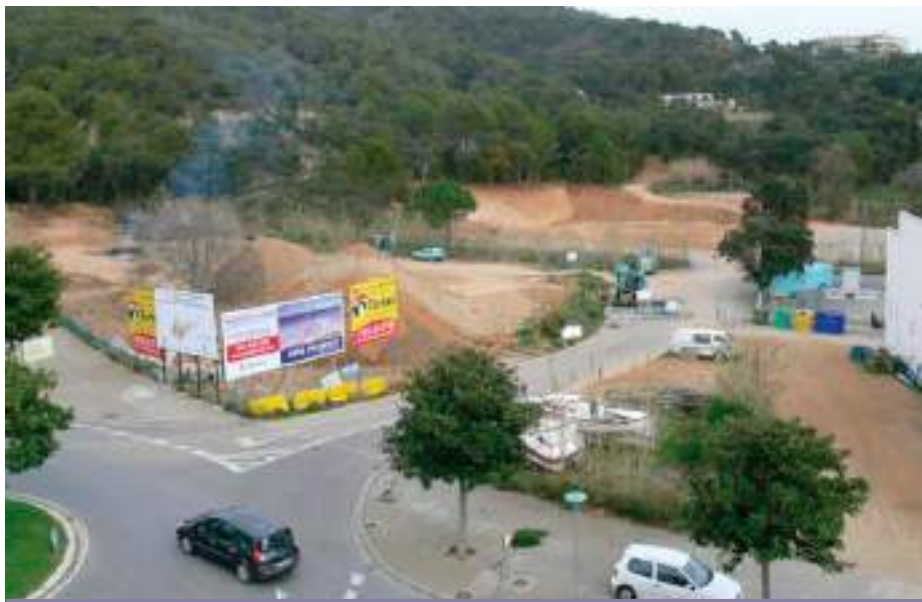
► Solar de la Porta de Sant Feliu on s'hi construeix un nou aparcament.
