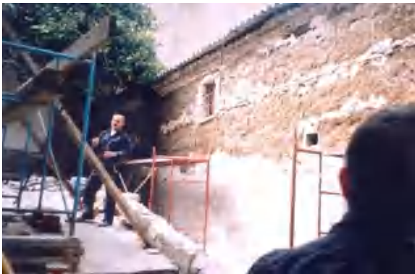
Façana posterior de Can Ganga, construïda com a paret de tàpia.
